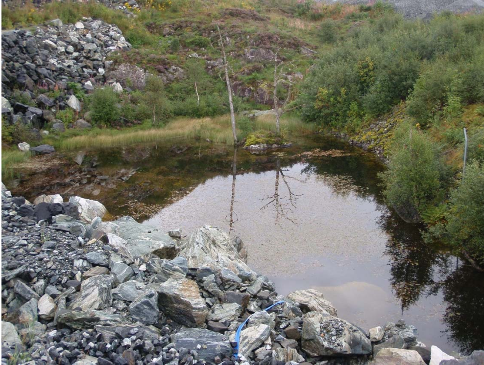
Figur 9. Sedimentasjonsdammen rett sør for deponi Nord, 04.09.2015. Bildet er tatt mot øst.
