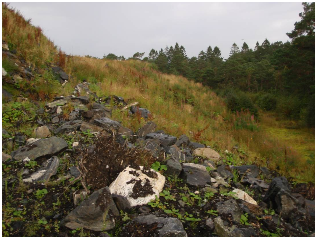
Figur E-7. Nordre del av østre voll rundt deponiet (felt 3), 04.09.2015. Bildet er tatt mot nord.
