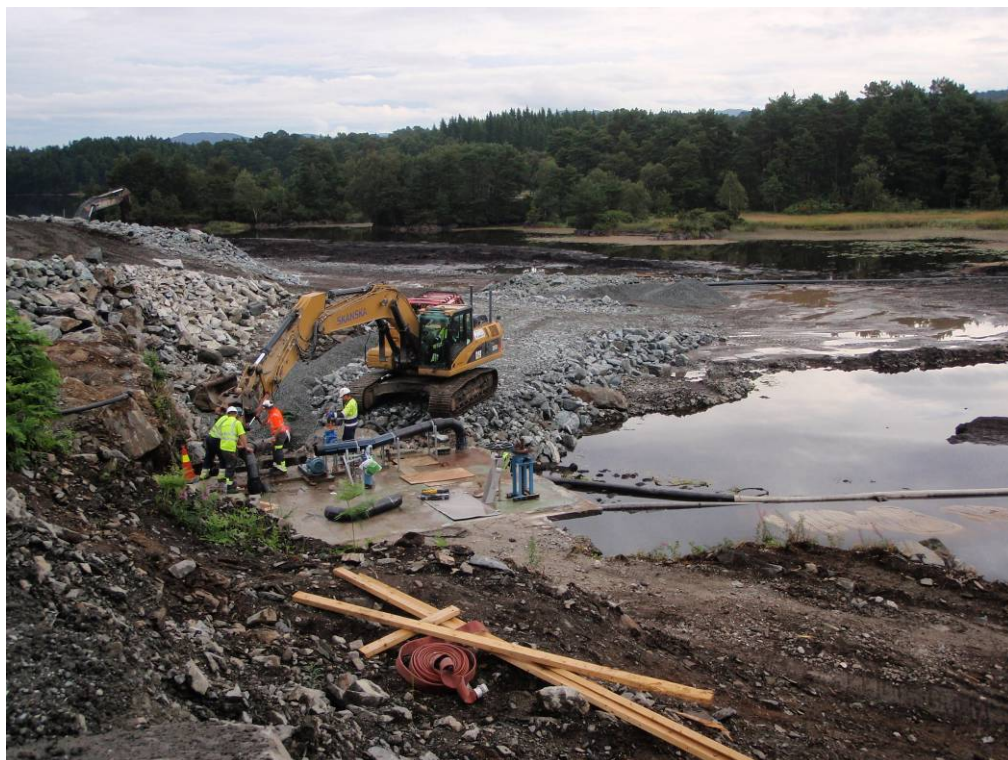
Figur 5. 11.08.2010. Anleggsarbeid og utfylling ved utløpspunktet. Bildet er tatt mot nordøst.
