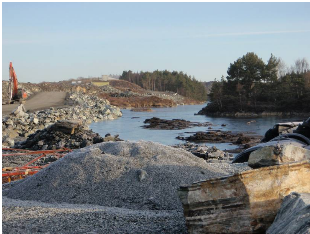
Figur 11. 30.03.2011. Ved utløpet. Bildet er tatt mot nord.
