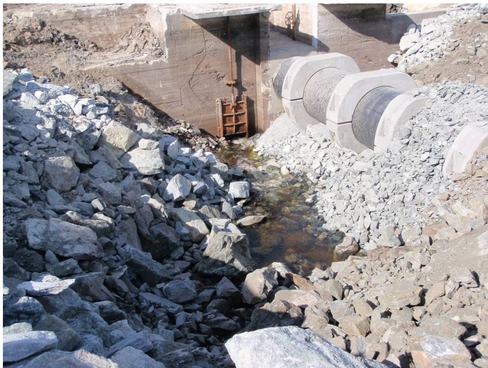
Figur 6. 08.09.2010. Utløp. Nytt utløpsrør i høyre del av bildet. Bildet er tatt mot vest
