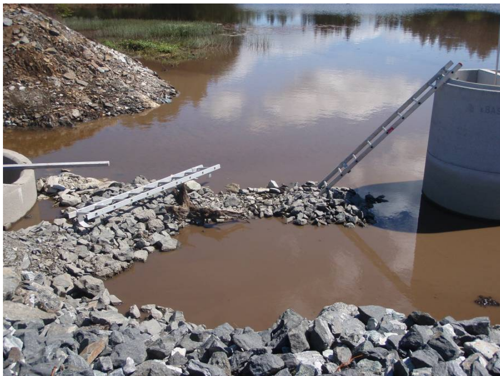
Figur 13. 06.06.2012. Ved utløpspunkt / VP 1. Graving i vannkanten pågår i nærheten.
