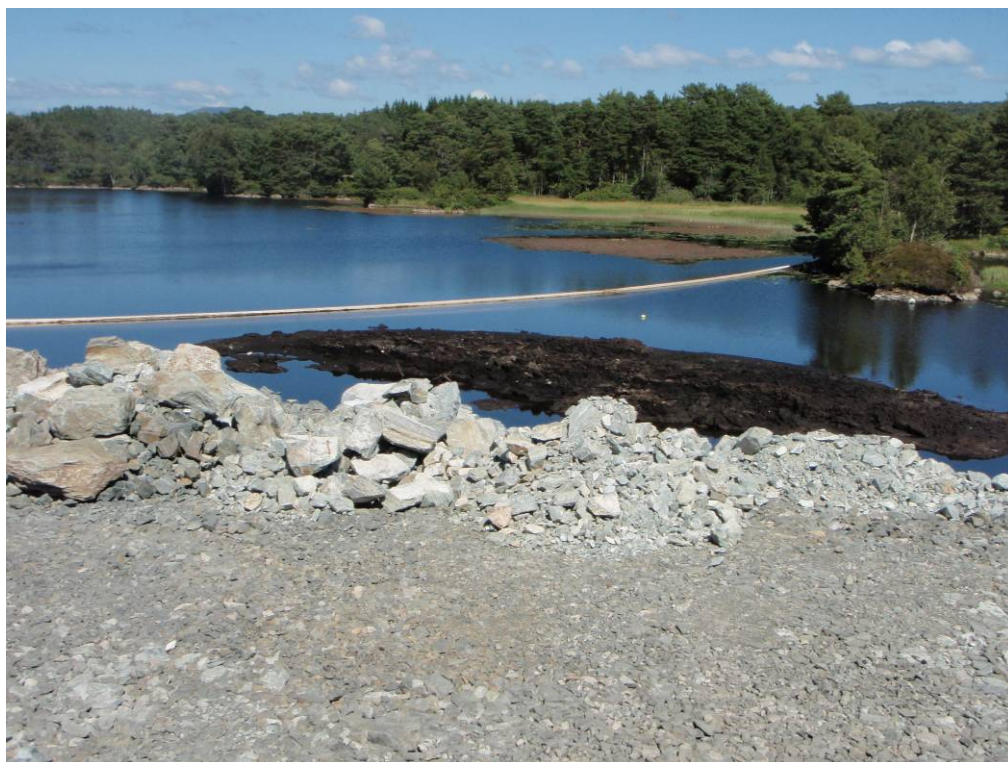
Figur 3. 14.07.2010. Siltgardin rett nord for utløpspunkt. Opp-presede bunnsedimenter. Bildet er tatt mot øst.
