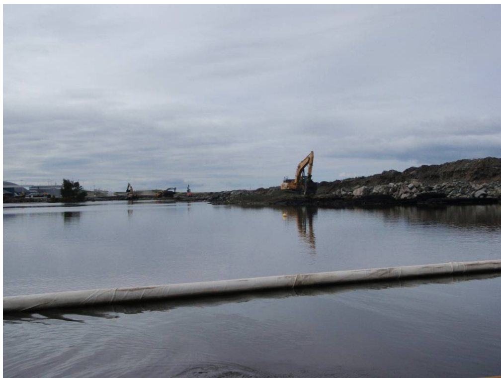
Figur 1. 16.06.2010. Siltgardin på sørsiden av utløpspunktet. Bildet tatt mot sørvest.
