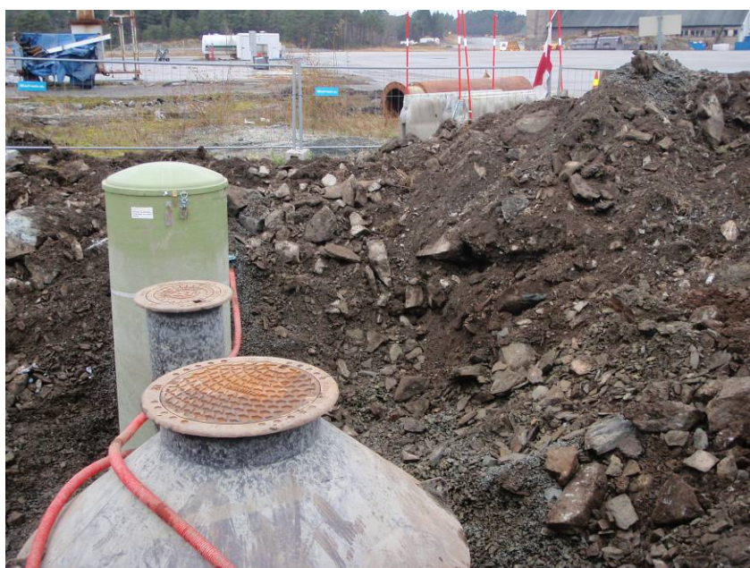
Figur 3. Nordre del av byggegropen (PG 47), sett mot nord.
