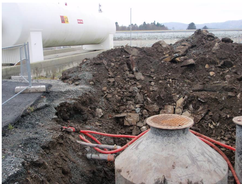
Figur 2. Søndre del av byggegropen (PG 46), sett mot sørvest.
