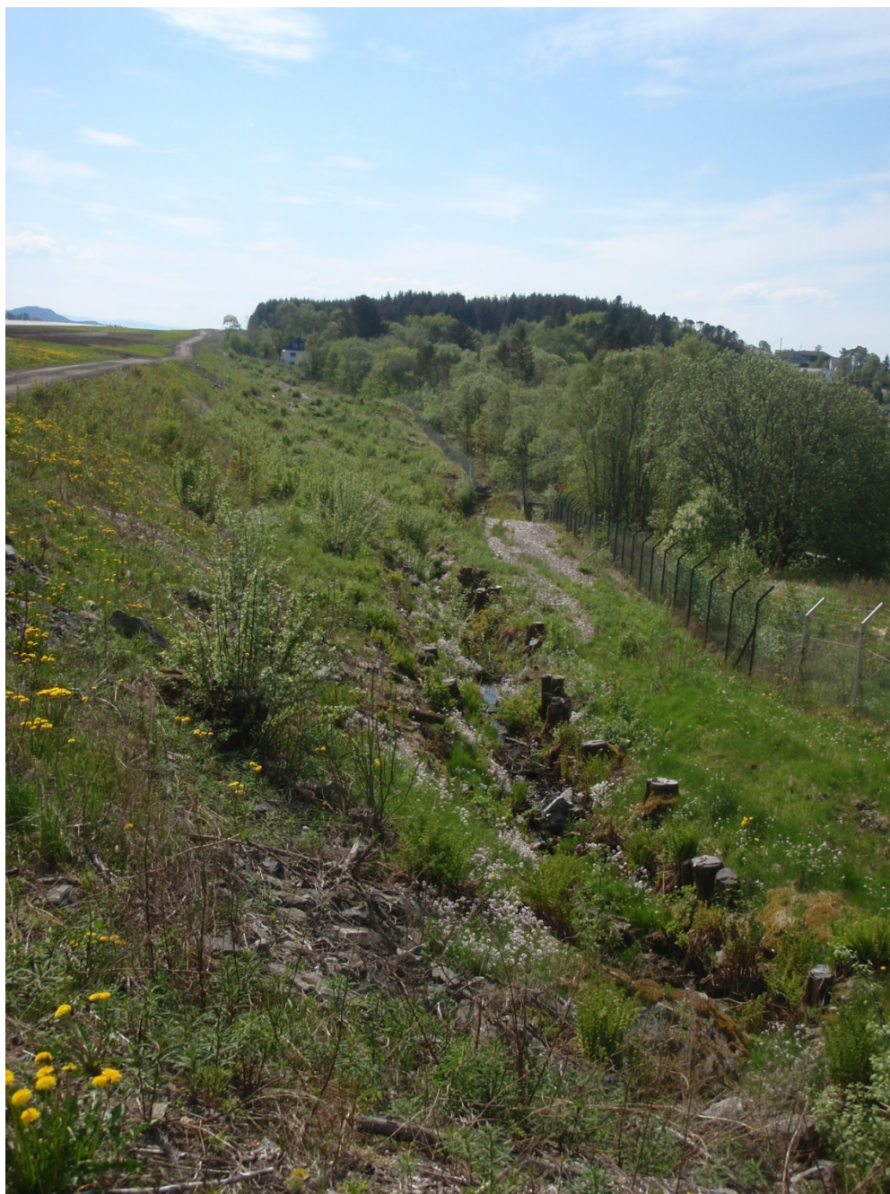
Figur B.2. Oversiktsbilde av vestre deler av området der Støyvoll 2 er planlagt. Bildet er tatt mot sør.
