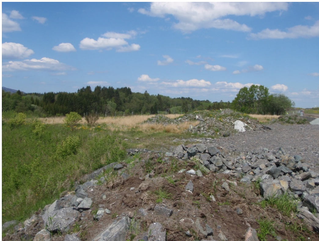
Figur F2. Oversiktsbilde av Delområdene 4 og 5 for Fylling 6. Bildet er tatt mot nord.
