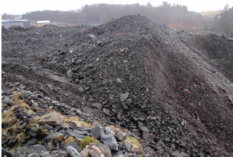
Figur 3. Masser fra bygging av ny taksebane. Massene er mellomlagret på steinlokket til deponi B. PG 1-PG 3 er tatt fra disse massene.
