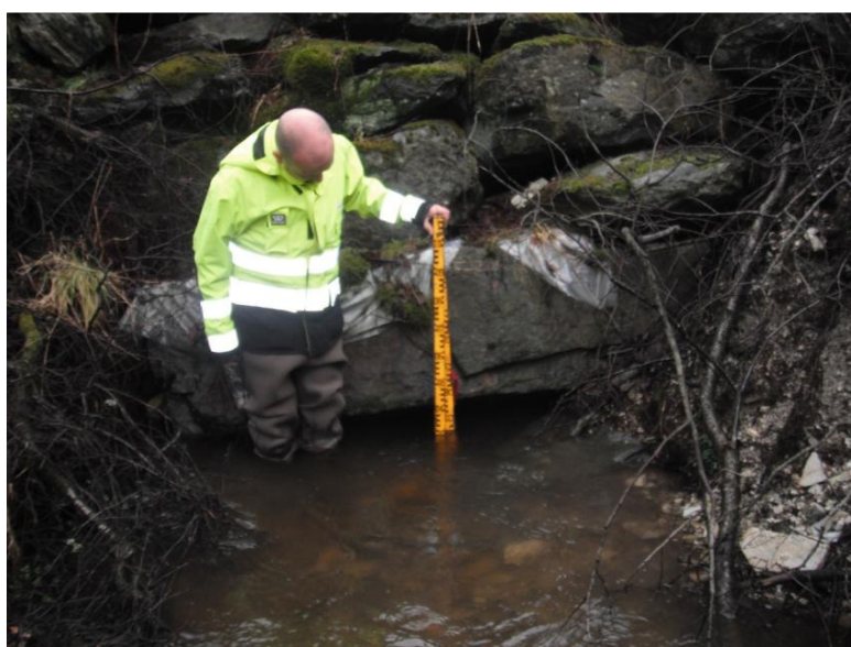
Figur 3: Utløp av kulvert under Fleslandsveien
