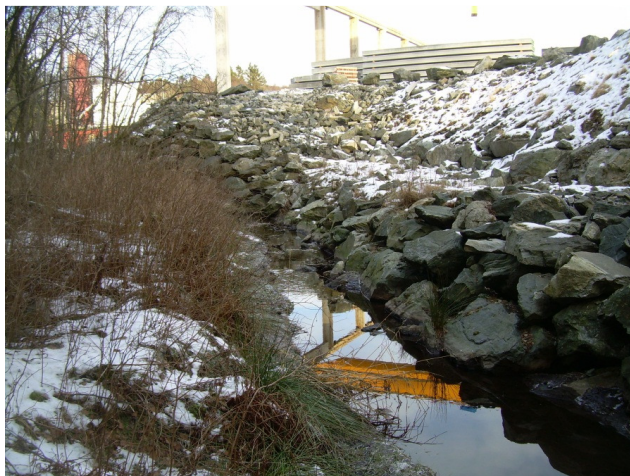
Figur V2.6: P4 (oppstrøms retning).
