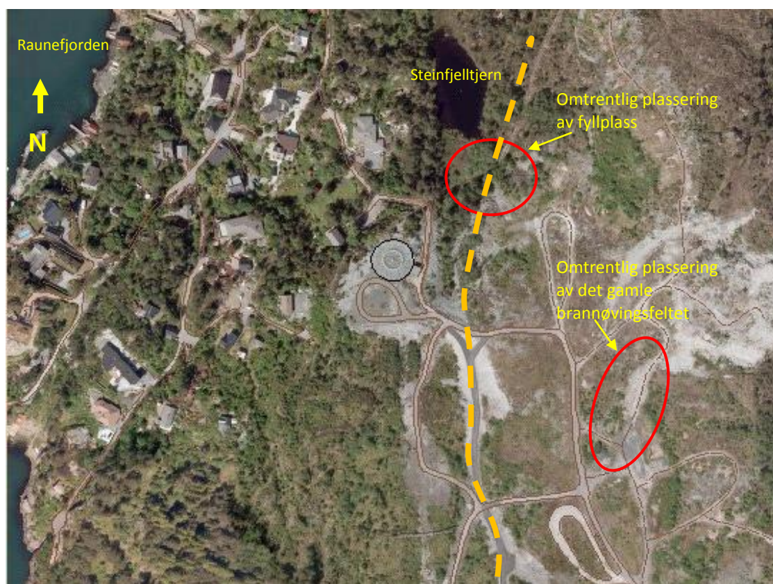
Figur 2.1: Oversiktsbilde over fyllplass nord, Steinfjelltjern og det gamle brannøvingsfeltet nord for flystripen på Bergen Lufthavn Flesland (kilde: www.bergenskart.no ). Omtrentlig plassering av den nye evakueringsveien er tegnet inn med oransje stiplet linje.
