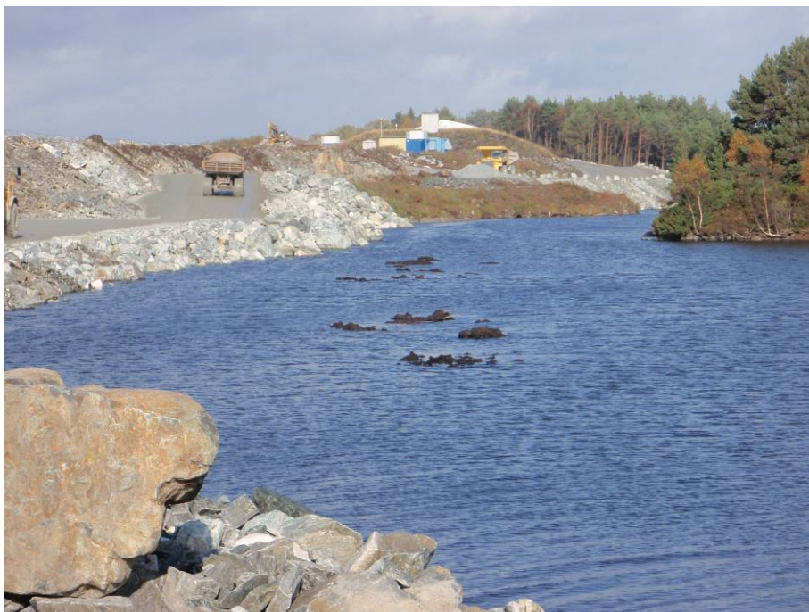
Figur 5. Oppressede sedimenter i området nord for utløpet. Bildet er tatt på prøvetakingsdagen, mot nord. Bildet viser omtrent normal vannstand.
