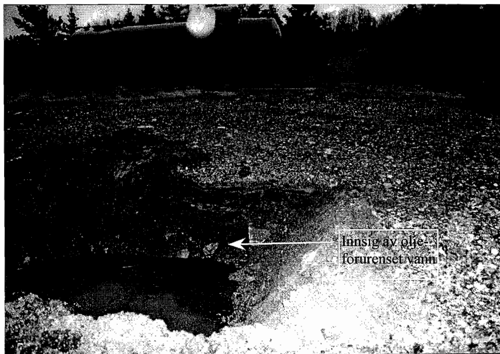
Fig 4.1 Inspeksjonsgrop vel 10 m vest for PG 2 som viser innsig av svart oljeforurensent vann.
