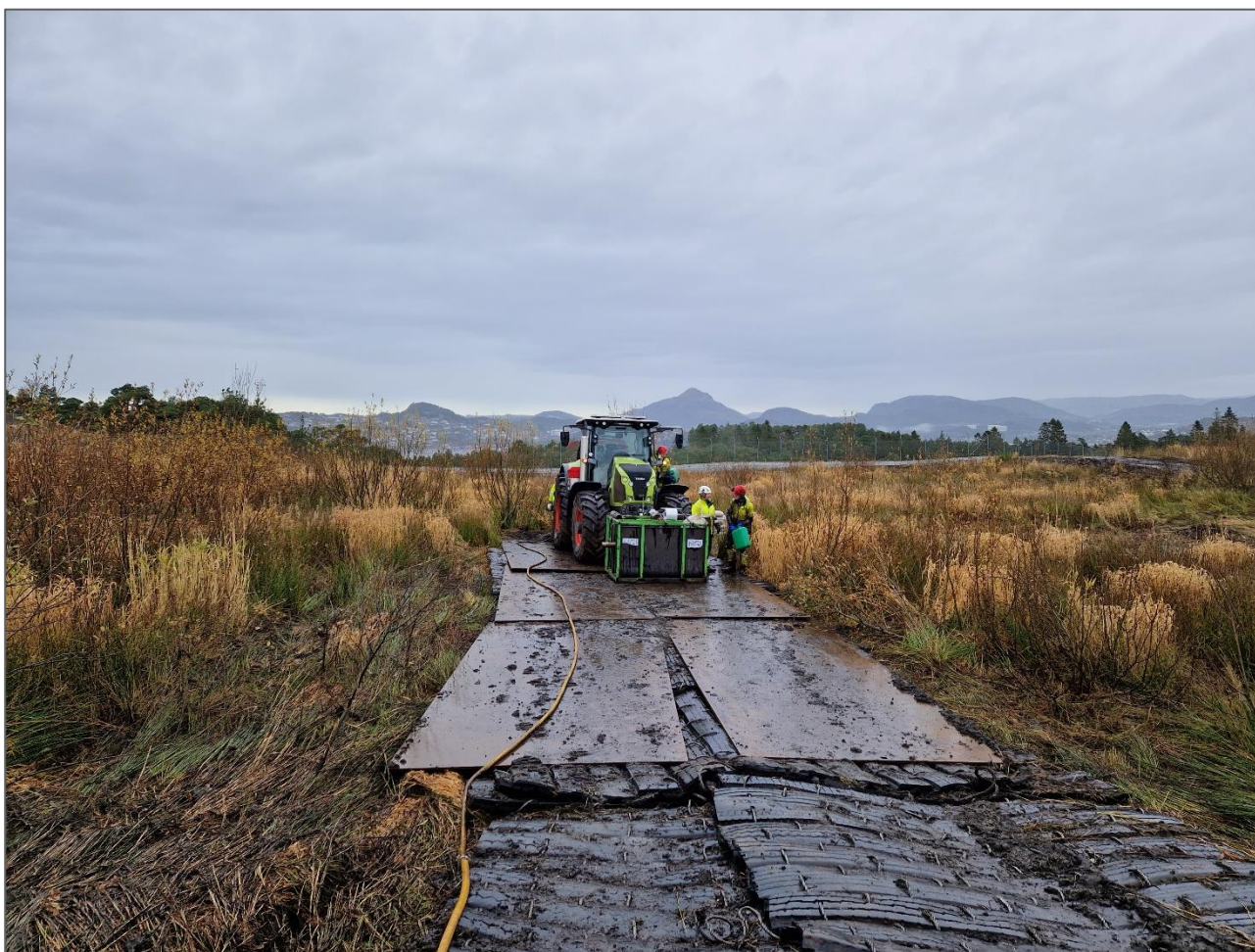
Figur 3-1: Sprengmatter og stålplater som ble lagt ut på de bløte delene av masselageret.
