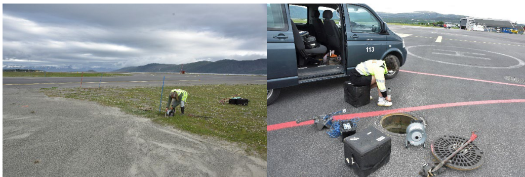
Figur 52. Bilde til venstre viser plasseringen av ENAT-OV3 prøvekummen like øst for taksebane Charlie. Sandfang
