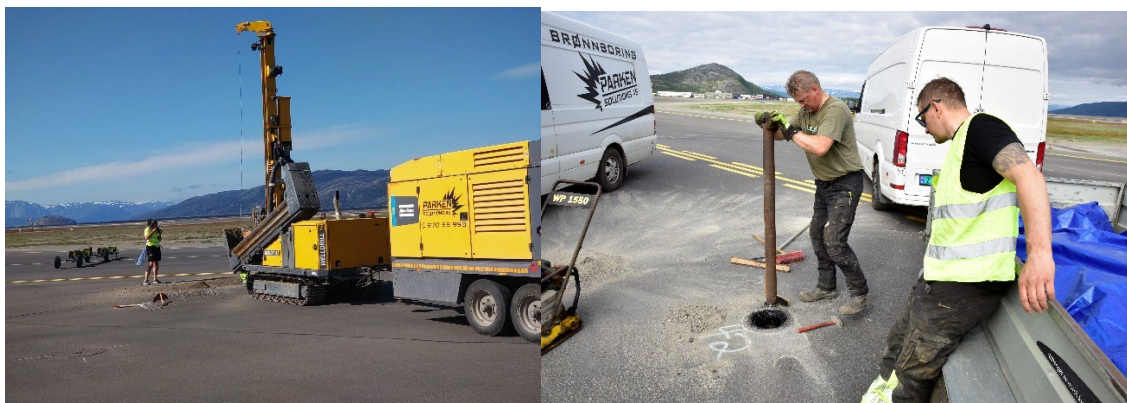
Figur 34. Bilde til venstre viser prøvetaking av i prøvepunkt ENAT-DB-GL-P41, og bildet til høyre viser re asfaltering av borehull ENAT-DB-PL-P42 på taksebane Charlie, utført dagen etter prøvetaking av mannskapene til innleid bore entreprenør, juni 2023 (Foto Tom Tellefsen).
