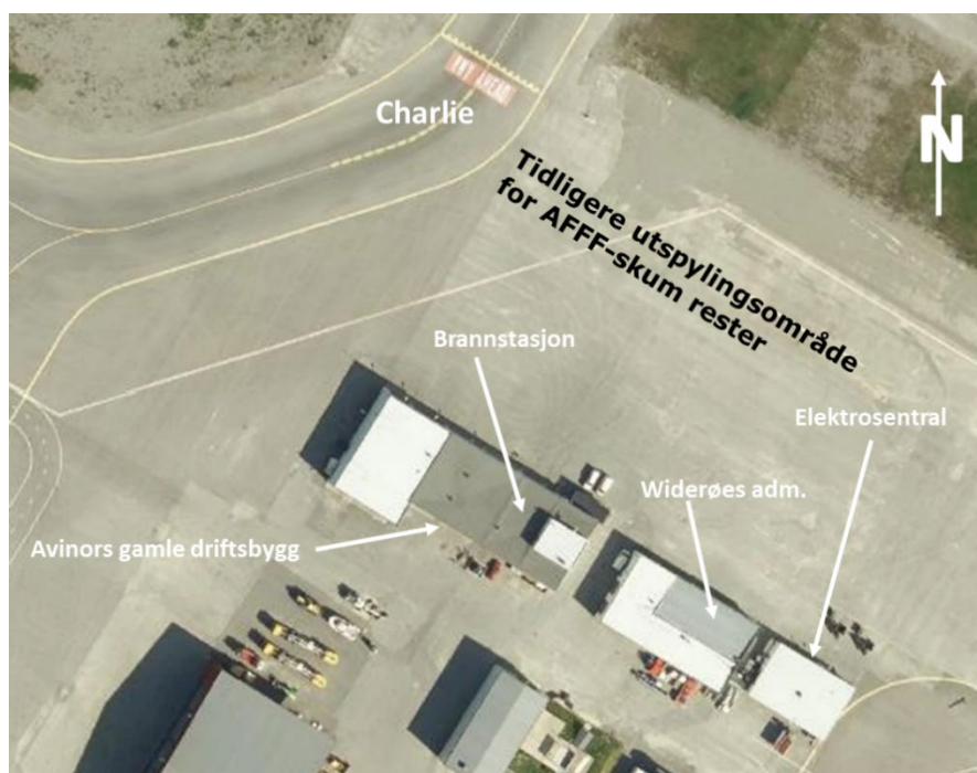
Figur 19. Flyfoto utsnitt som viser plasseringen av de gamle driftsbygningene som nå er fjernet på Alta lufthavn (Avinors gamle driftsbygg, brannstasjon, Widerøes adm., elektrocentral), samt lufthavnas hovedtrafikkåre Charlie.
