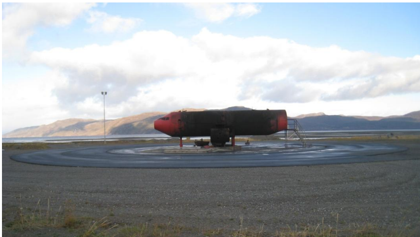
Figur 2: Bilde av brannøvingsfelt.
