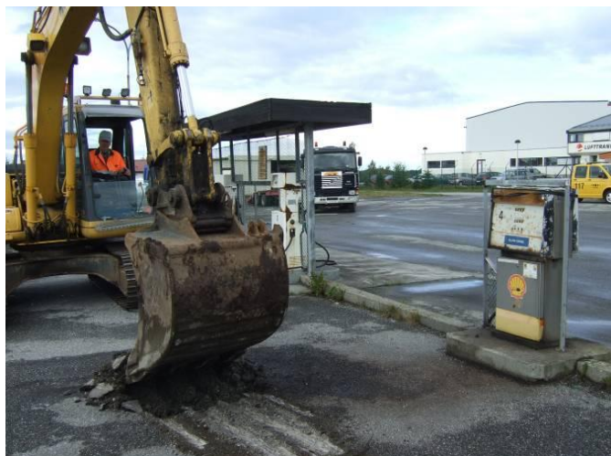
Figur 3. Graving ved pumpeanlegg, sjakt 4
