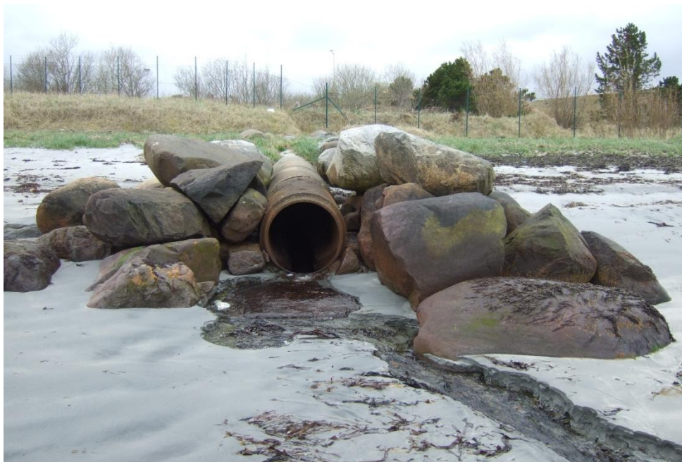
Figur 5: Bilde som viser utløpspunktet for overvannsledning mot øst i Roaldsleira. Utløpet for denne OV-ledningen er lagt om i desember 2012, pga. krav i utslippstillatelse. ( Forlenget ut til 2 m dyp på lavvann)
