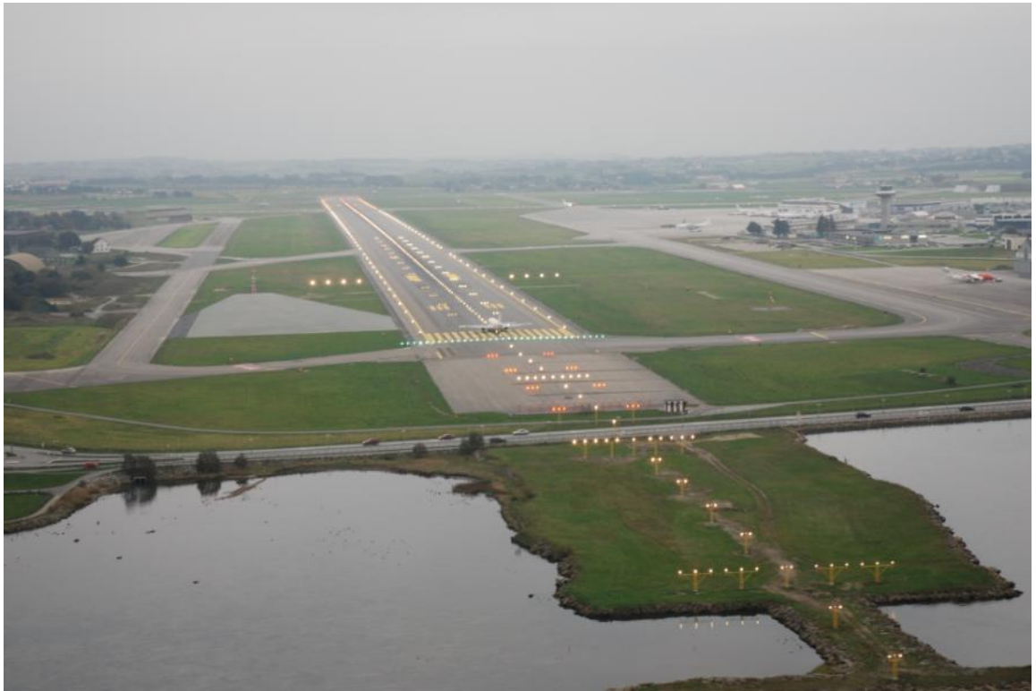
Figur 2 Rullebanen med CAT-II-belysning. Foto: Helge Nyhus/Avinor
