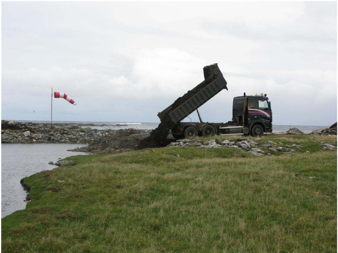
Figur 5. Utfylling i vaderbukta nord for lufthavna høsten 2009 i forbindelse med opparbeidelse av utsetningsrampe for utrykningsbåt.
