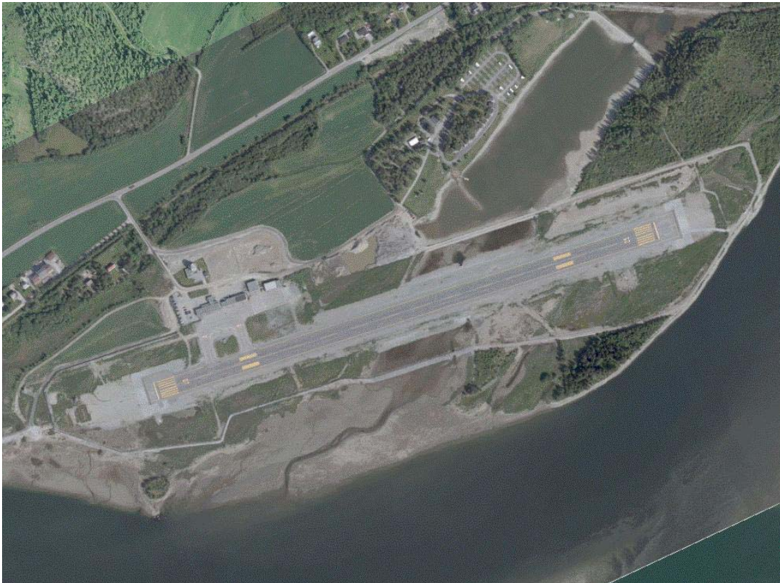
Figur 3 Namsos lufthavn. Ortofoto. Foto Avinor.
