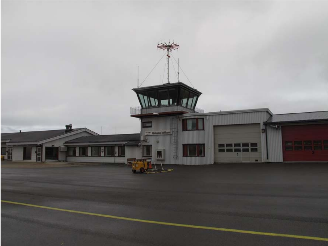
Figur 1. Terminalbygget Mehamn lufthavn. Foto: Rune Solvang.
