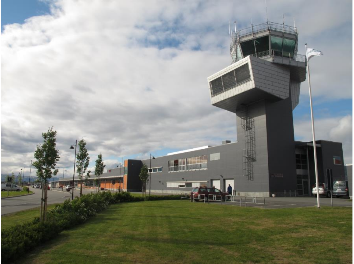
Figur 1. Terminalbygget Alta lufthavn. Foto: Rune Solvang.
