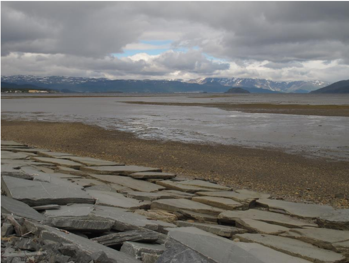
Figur 5. Fyllmassene som lufthavna ligger på er beskyttet med altaskifer mot Altafjorden. Foto: Rune Solvang.
