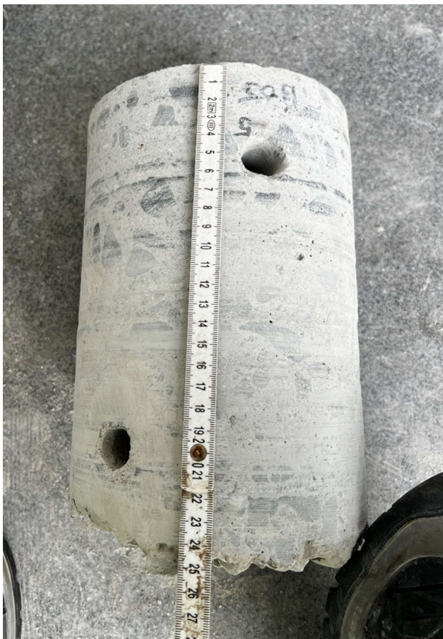
Figur 3-2: Bilde av kjerneprøve (BO5) fra betongplaten, som viser de mindre borehullene for prøvetaking av betong på hhv. 5 cm og 20 cm under overflaten av betongplaten.
